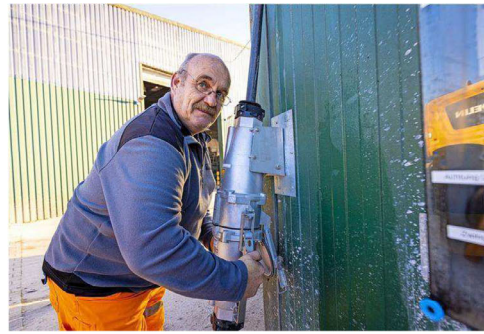
Baggerfahrer Thomas Mislintat kontrolliert die riesige Steckdose, die den Elektrobagger über ein Kabel dauerhaft mit Strom versorgt. Die Firma Damm hat extra für den E-Bagger 300 Meter Erdkabel auf dem Gelände des Recyclinghofes in Grambek verlegt und neue Anschlussdosen wie diese eingerichtet. Quelle: Agentur 54*
